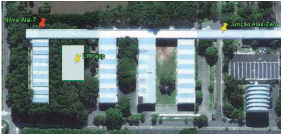
Figura 8.44 – construção da Ala-7 e junção às demais Alas do E-2
